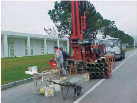
foto 3: esecuzione sondaggio geognostico reperito S1-pz1 strumentato a piezometro effettuato all'interno dell'edificio Tod's
